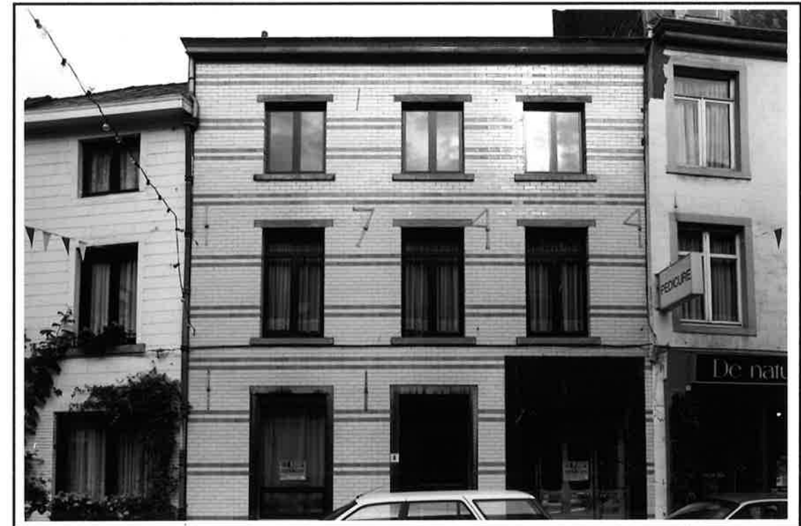
Brusselsesteenweg 5 met muurankers gedateerd 1744, huidige toestand.
