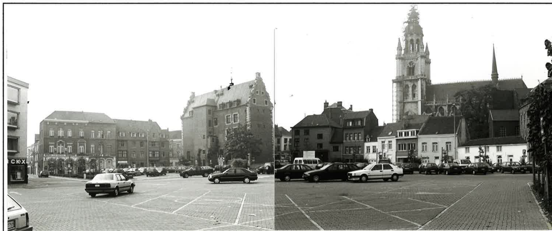
Possozplein met achtergevel van het stadhuis, huidige toestand.
