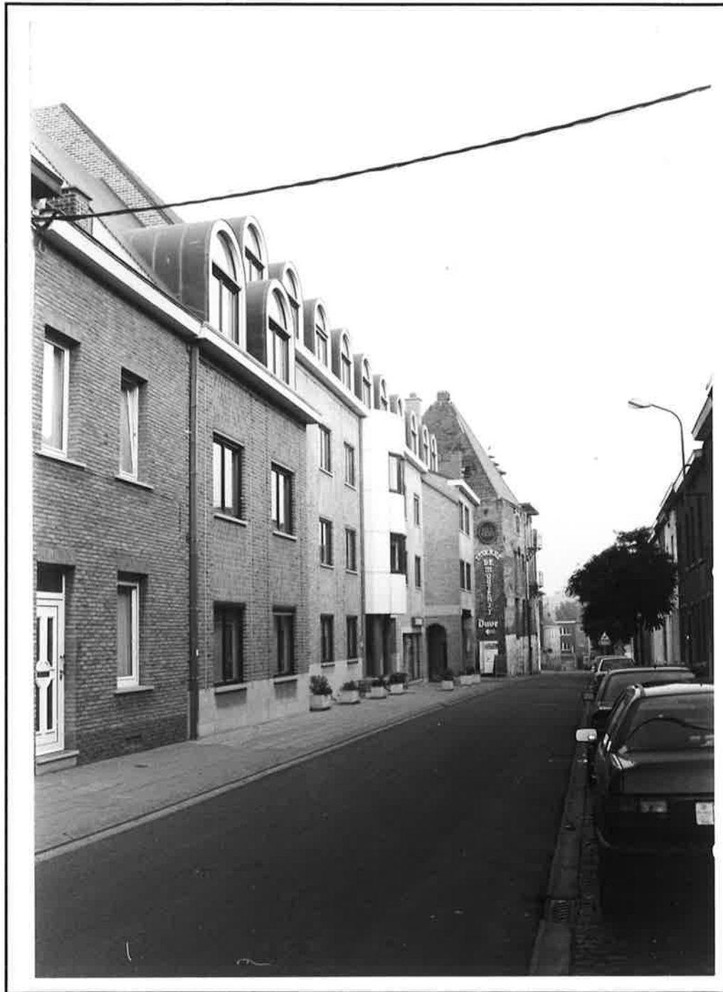
Verstoorde gabariet en rooilijn in de Meiboom door de nieuwe appartementsgebouwen, huidige toestand.
